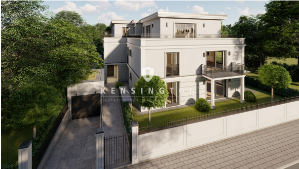
Außenansicht von der Straßenseite
