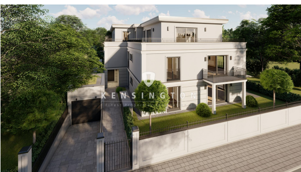
Außenansicht von der Straßenseite
